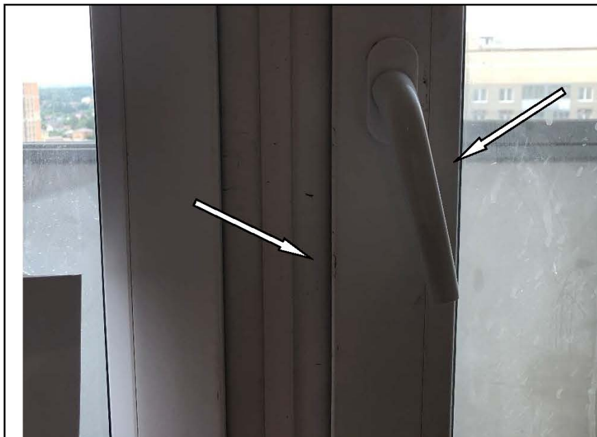
Фото №28. Регулировка фурнитуры балконного дверного блока, царапины на ПВХ профиле в кухне.
