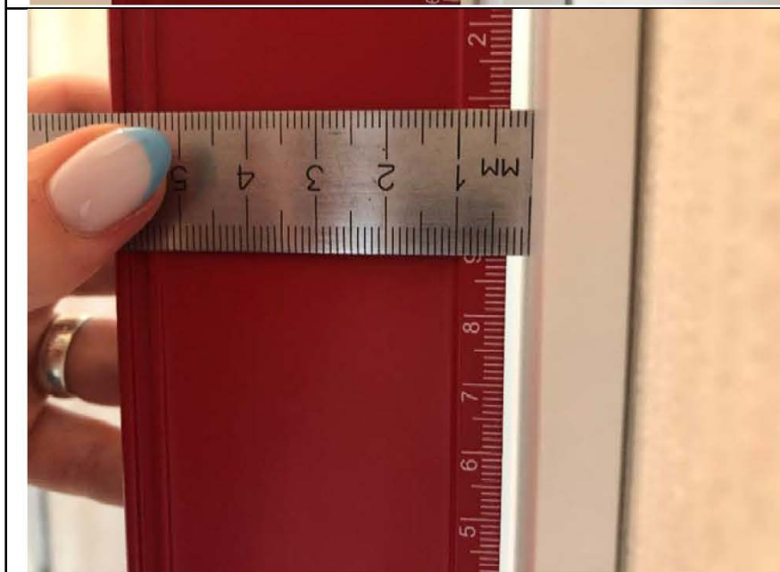
Фото №15. Измерение уровня наличника двери в ванной комнате.
