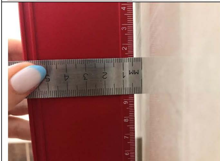
Фото №9. Измерение уровня стен ванной комнаты в квартире.
