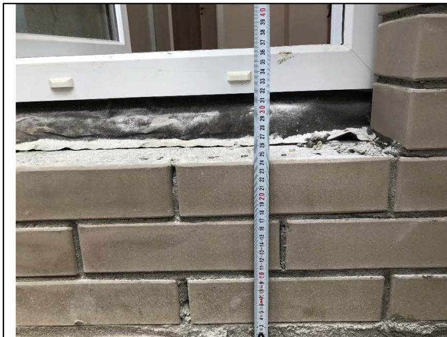
Фото №46. Измерение высоты ступени на лоджии в квартире.
