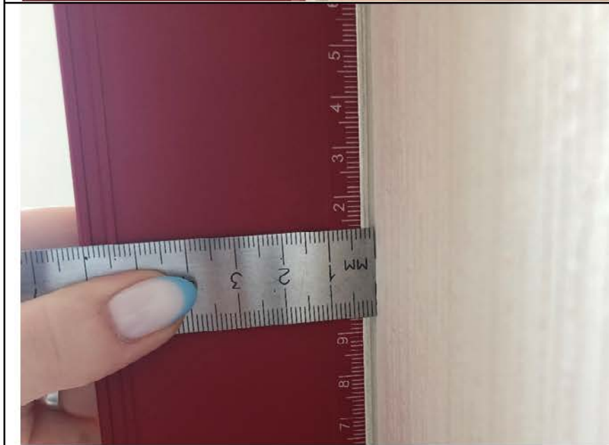
Фото №8. Измерение уровня стен спальни в квартире.
