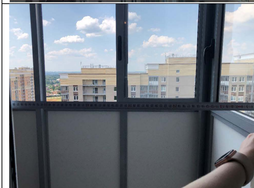
Фото №27. Измерение светового просвета балконной двери на лоджии.
