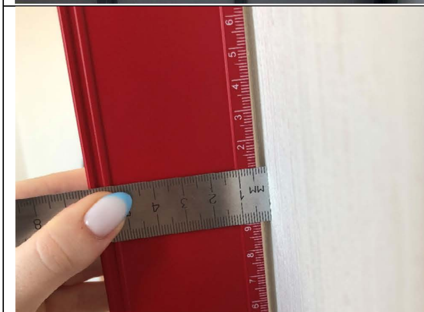
Фото №6. Измерение уровня стен кухни в квартире.
